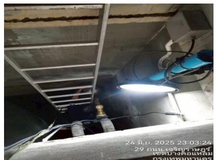
ล้างถังเก็บน้ำสำรองและตรวจเช็คสภาพถังเก็บน้ำสำรอง ประจำปี 2568 (24 มิถุนายน 2568) รูปที่ 2.1-9 ระบบน้ำใช้โครงการ (ต่อ)
