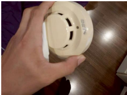
งานบำรุงรักษาตรวจเช็คระบบ Fire Alarm (เปลี่ยน smoke detector)
