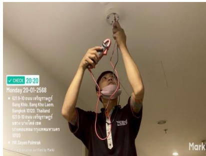
งานบำรุงรักษาตรวจเช็คระบบ Fire Alarm (เปลี่ยน smoke detector)
