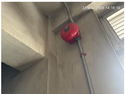
กริ่งส่งสัญญาณแจ้งเตือน
