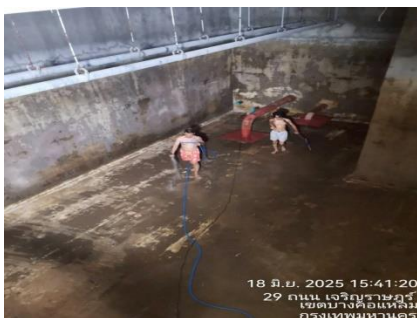
ล้างถังเก็บน้ำสำรองและตรวจเช็คสภาพถังเก็บน้ำสำรอง ประจำปี 2568 (24 มิถุนายน 2568) รูปที่ 2.1-9 ระบบน้ำใช้โครงการ (ต่อ)
