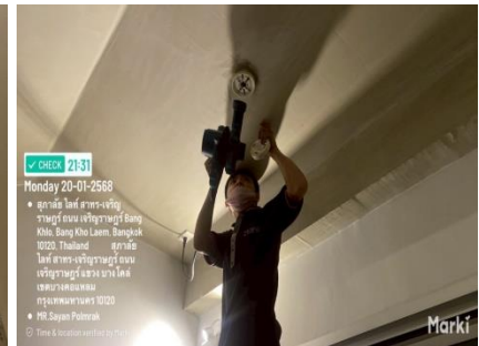
งานบำรุงรักษาตรวจเช็คระบบ Fire Alarm (เปลี่ยน smoke detector)
