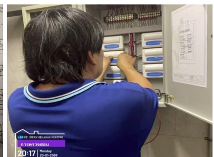
งานบำรุงรักษาตรวจเช็คระบบ Fire Alarm (เปลี่ยน smoke detector)
