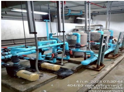
ตรวจสอบระบบปั๊มน้ำสระว่ายน้ำ
