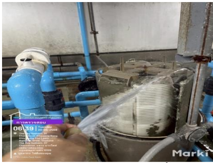
เจ้าหน้าที่ตรวจสอบระบบกรองน้ำสระว่ายน้ำ
