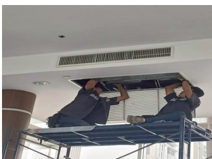
รูปที่ 2.1-17 ตรวจสอบบำรุงรักษาระบบปรับอากาศ (ส่วนกลาง)
