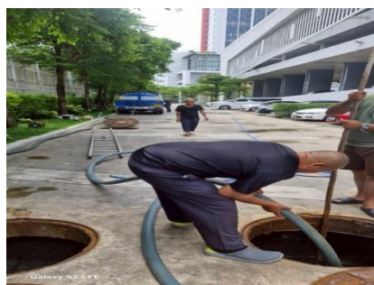
สูบลบเกราะ กากตะกอนส่วนเกินระบบบำบัดน้ำเสีย ประจำปี 2568
