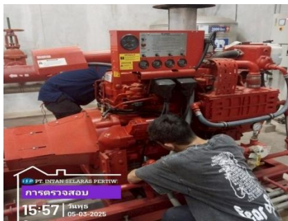
งานบำรุงรักษาตรวจใช้ระบบปั๊มสูบน้ำดับเพลิง
